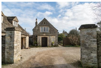
Coppice Cottage, Coppice Lane
